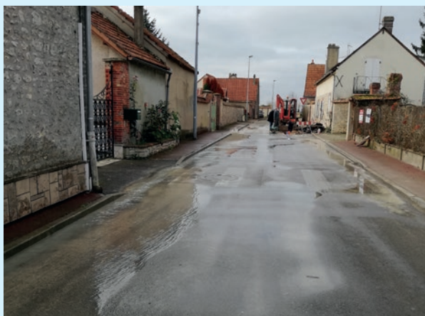
Fuites d'eau à répétition Grande Rue.
